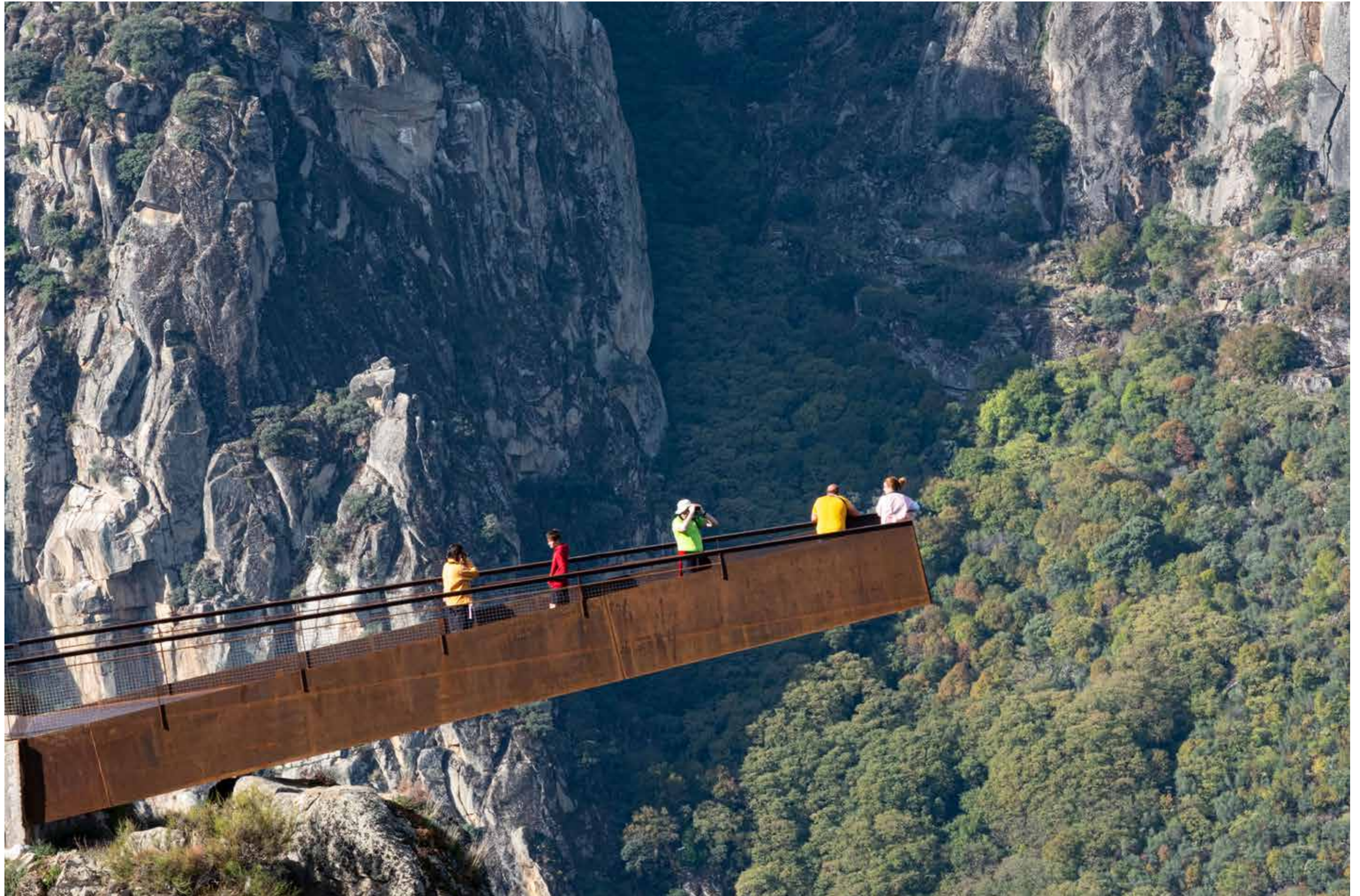
Mirador del Fraile sobre el río Duero
